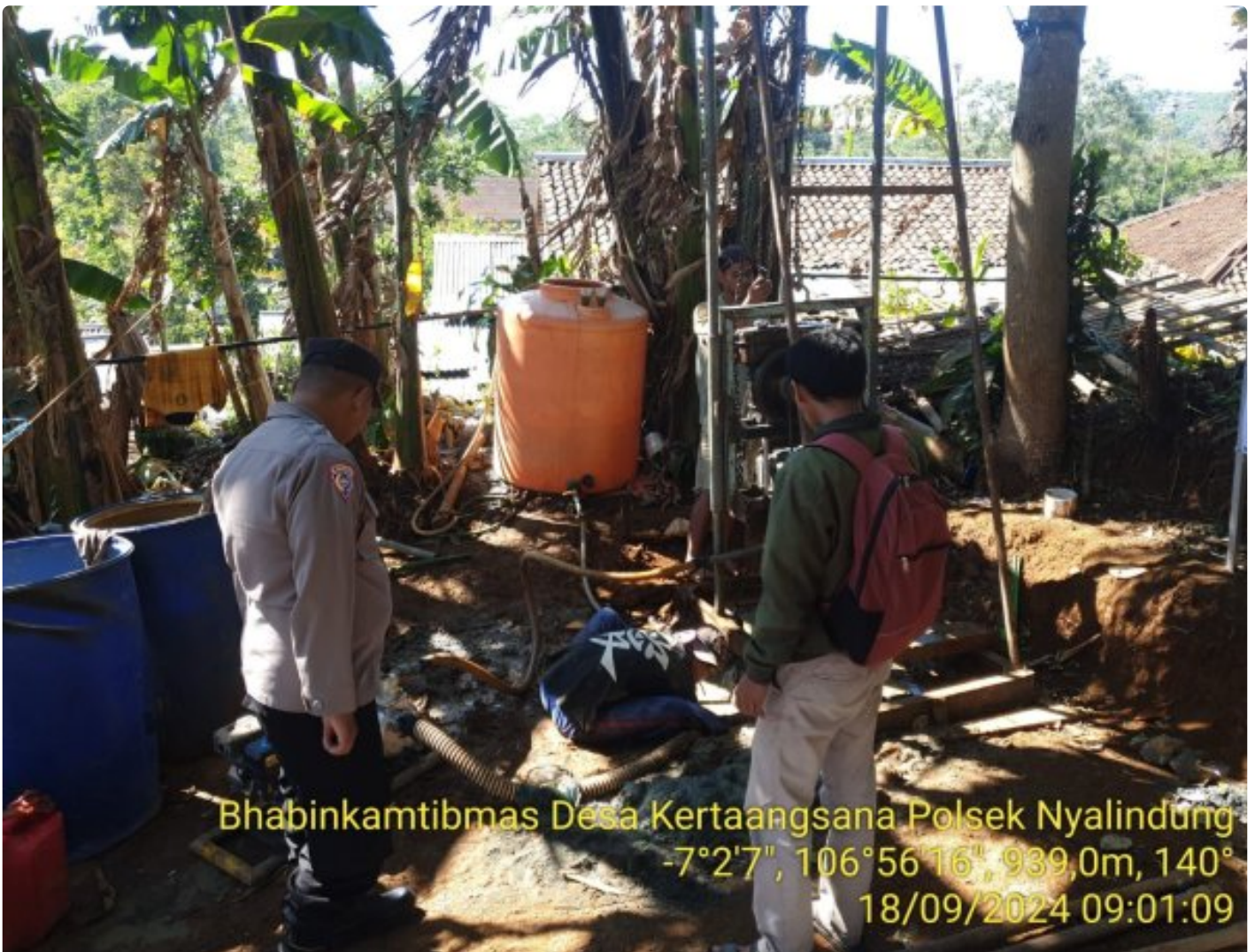
Monitoring Pembangunan Sumur Bor di Desa Kertaangsana oleh Bhabinkamtibmas Polsek Nyalindung
