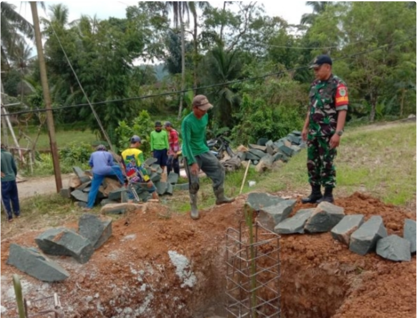
Giat Bakti Pembangunan Jembatan Gantung di Koramil Jampangkulon Bantuan Pangdam III/Siliwangi
