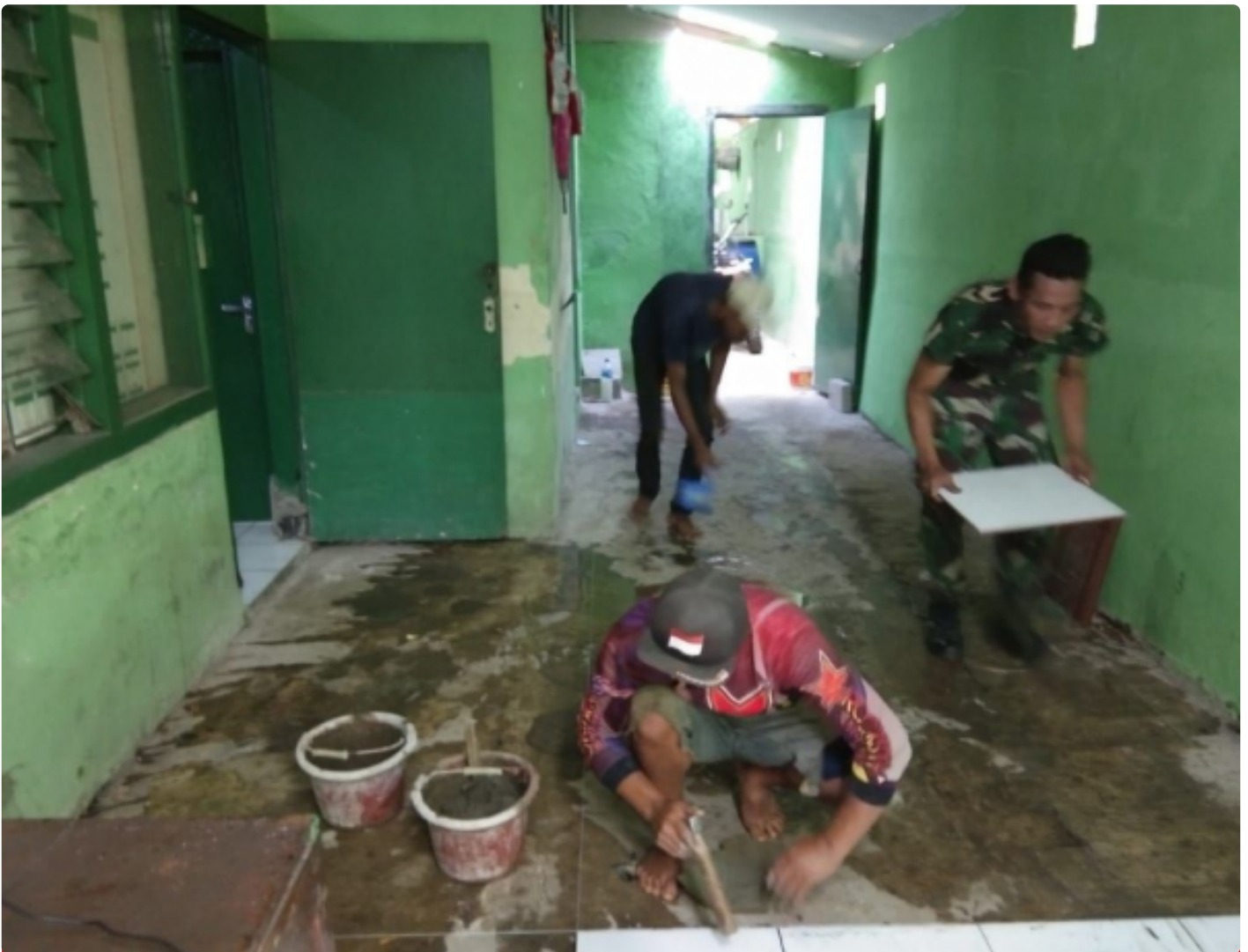
Koramil 0622-04/Cikidang Lakukan Perbaikan dan Pemeliharaan Kantornya
