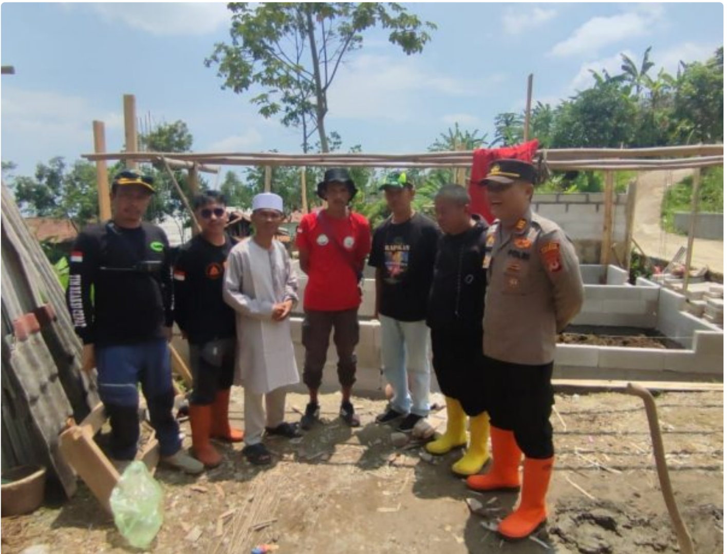
Kapolsek Cidahu Akhmad Suryana Gotong Royong Bersama Warga Perbaiki Rumah yang terkena Bencana Alam
